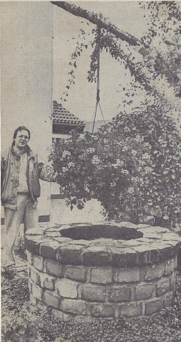
DER BRUNNEN vor dem Haus Bennert 15 erinnert an ein tragisches Geschehen aus dem Jahr 1909: Beim Einsturz des Schulbrunnens wurden Pumpenmacher Friedrich Schmitz getötet, dessen Sohn sowie Lehrer Jaeger schwer verletzt. Bilder: Holger Schmitt
